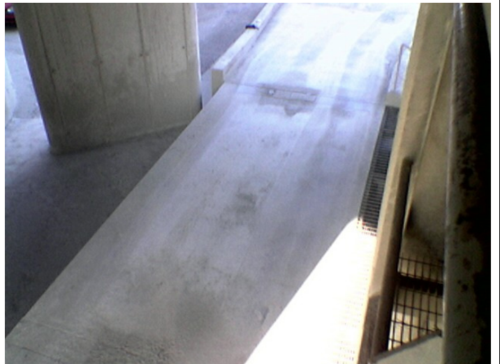
PESE A PONTE MODULARI CON PIATTAFORMA IN CEMENTO
