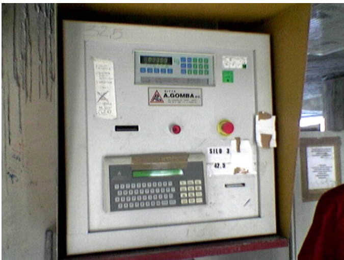
QUADRO DI CONTROLLO CON TERMINALI DI PESATURA "S / G "
