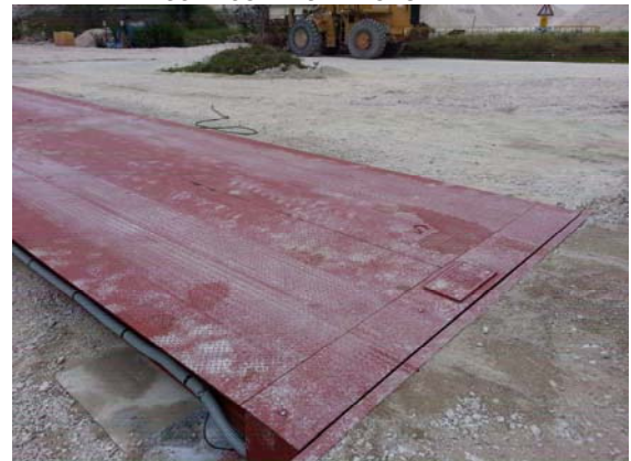
REALIZZAZIONE DELLE RAMPE IN PIETRISCO
