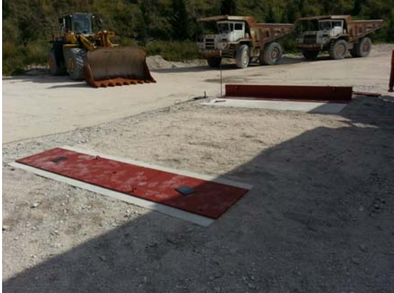
SISTEMAZIONE DELLE PIASTRE DI APPOGGIO
