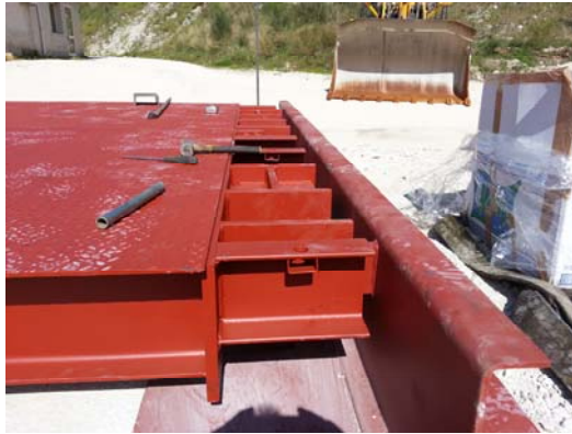
MONTAGGIO DEI PANNELLI
