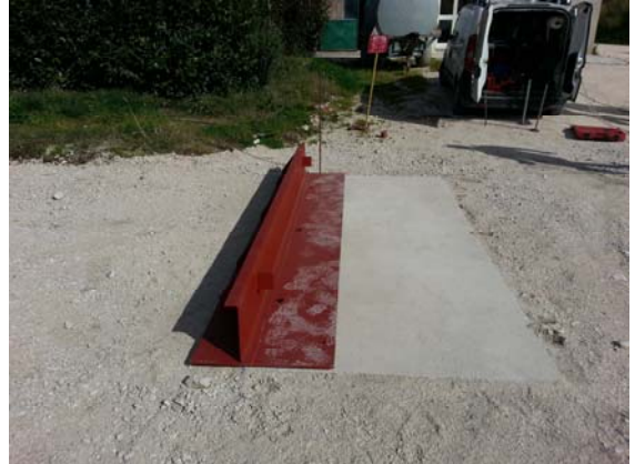
FISSAGGIO DELLE PIASTRE DI ESTREMITA'
