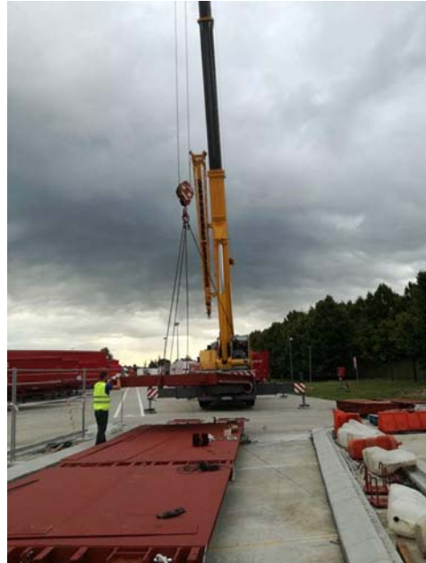
FASE DI SCARICO DEI SEMIPANNELLI
