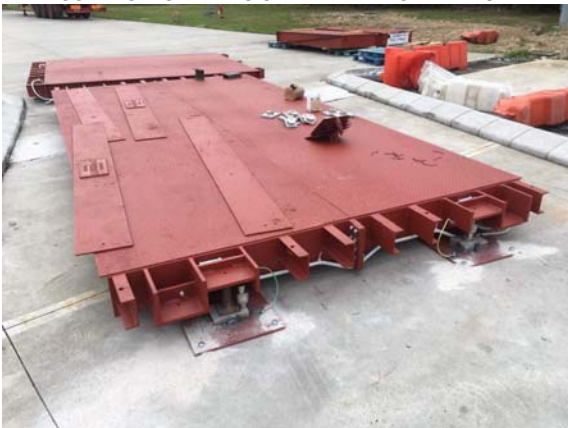
ASSEMBLAGGIO DEI SEMIPANNELLI
