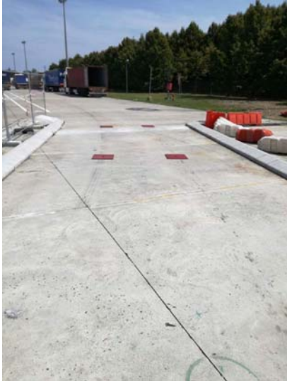
CONTROLLO DIMENSIONALE DELLE OPERE MURARIE
