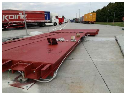
POSIZIONAMENTO DELLE CELLE DI CARICO
