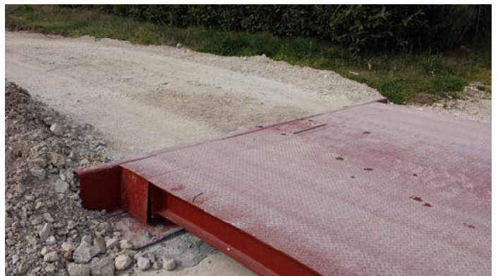
Realizzazione delle rampe di accesso con pietrisco riportato
