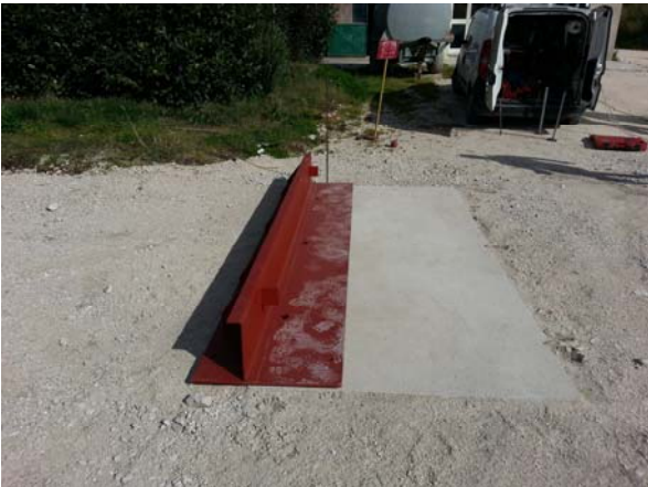
Montaggio della piastra di testata
