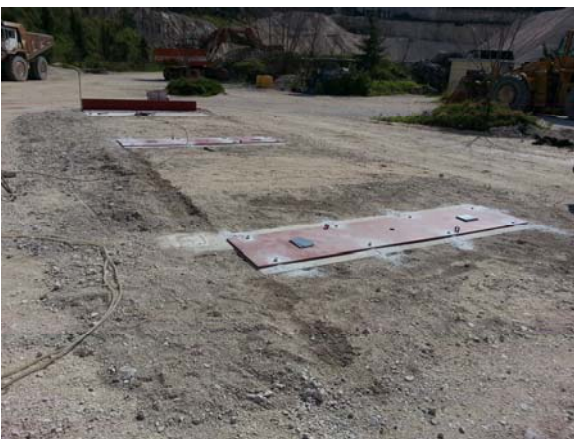
Montaggio delle piastre di appoggio
