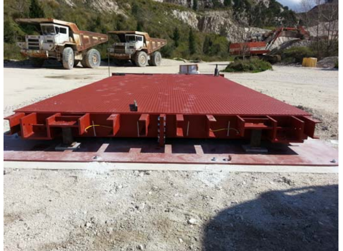
Posizionamento dei moduli sulle piastre di appoggio
