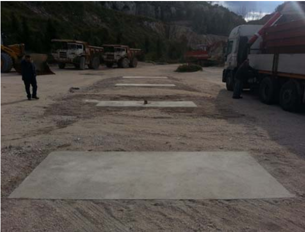
Realizzazione delle basi in cemento
